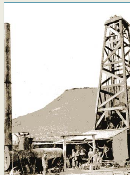
Diciembre 1907, Comodoro Rivadavia. Unidad de perforación (sistema Fauck) operando en el Pozo N° 2.
